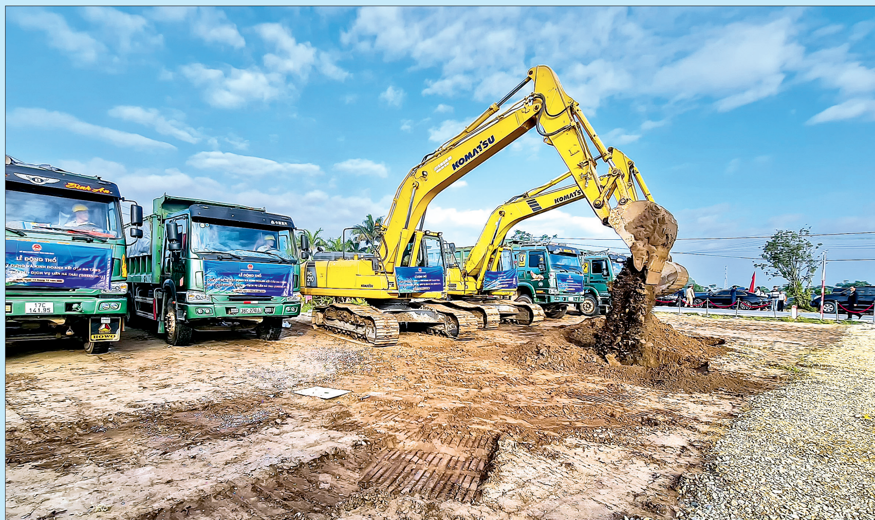
Công ty Cổ phần Green I-Park tập trung phương tiện, nhân lực triển khai các hạng mục hạ tầng khu công nghiệp - đô thị - dịch vụ Liên Hà Thái.
