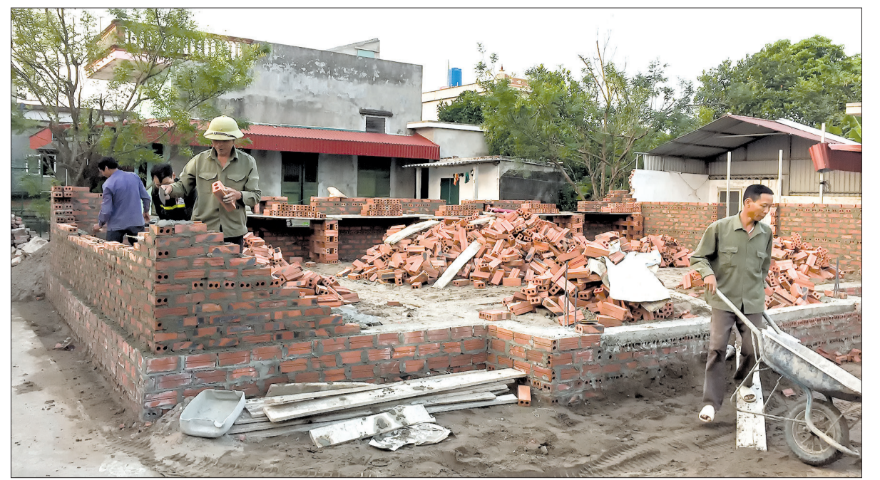
Xây dựng nhà ở cho người có công tại xã Thái Phúc (Thái Thụy).
