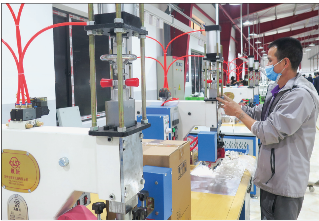
Công ty TNHH Mạnh La đẩy nhanh tiến độ lắp đặt máy móc, đưa nhà máy đi vào hoạt động 100% công suất ngay trong quý I/2022.
