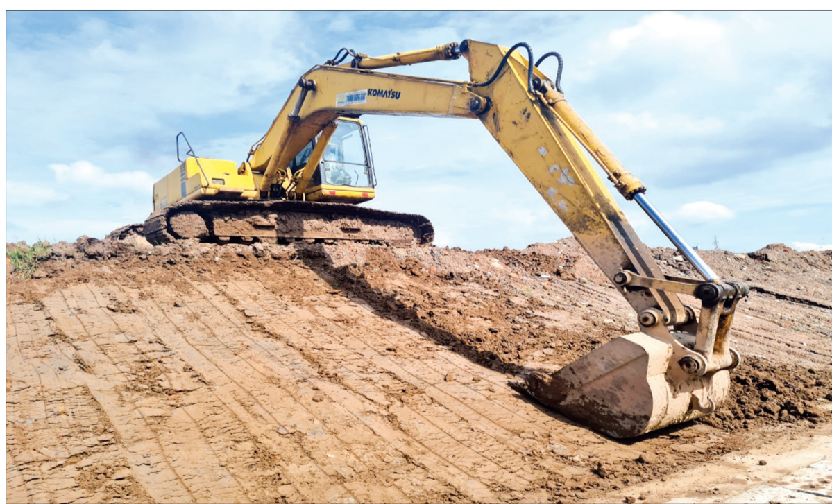
Thi công kê chính trang mái để đoạn qua khu vực Quảng trường Thái Bình.
