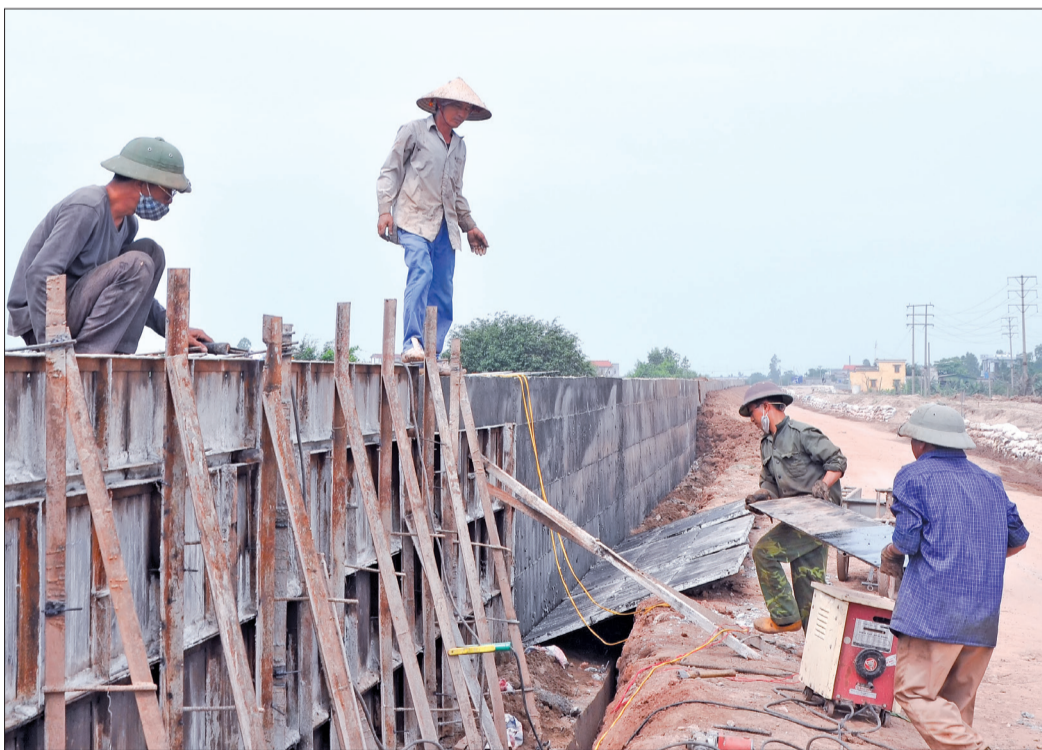
Thi công đê tả sông Diêm Hộ, đoạn qua xã Thụy Liên (Thái Thụy).
