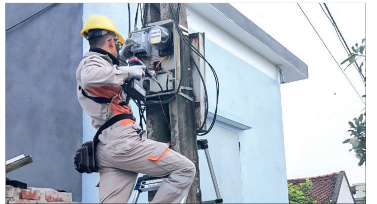
Điện lực Thái Thụy lắp đặt công tơ điện tử trên địa bàn xã Hồng Dũng.
