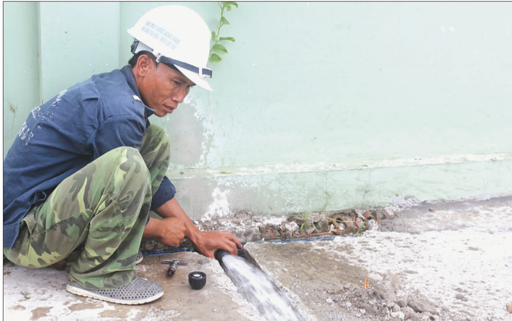
Công nhân Công ty TNHH Thương mại Đỗ Gia Bảo đấu nổi nước sạch cho các hộ dân xã Đông Quang.
