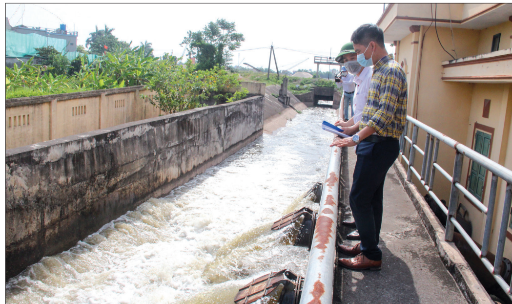
Vận hành chạy thử trạm bơm Đông Tây Sơn (thành phố Thái Bình).
