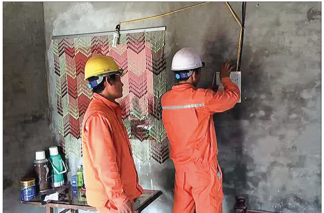
Công ty Điện lực Thái Bình lắp đặt đường dây mới cho hộ nghèo, gia đình chính sách.
