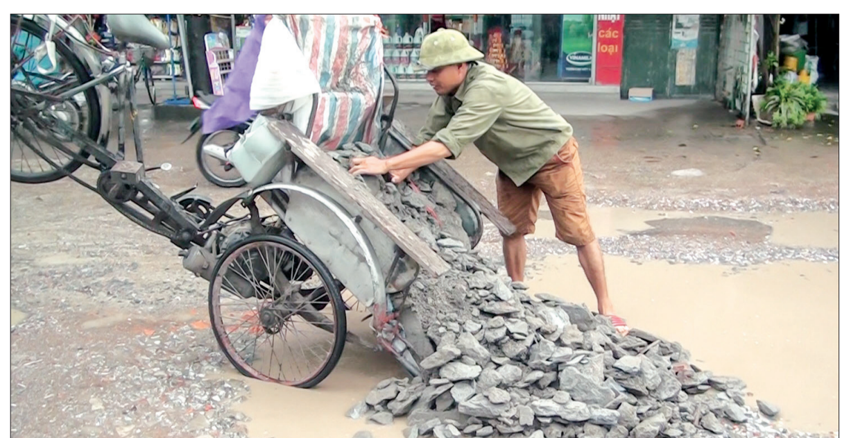
Người dân sống quanh đoạn đường chỉ và vũng tạm thời bằng các vật liệu phế thải xây dựng.
