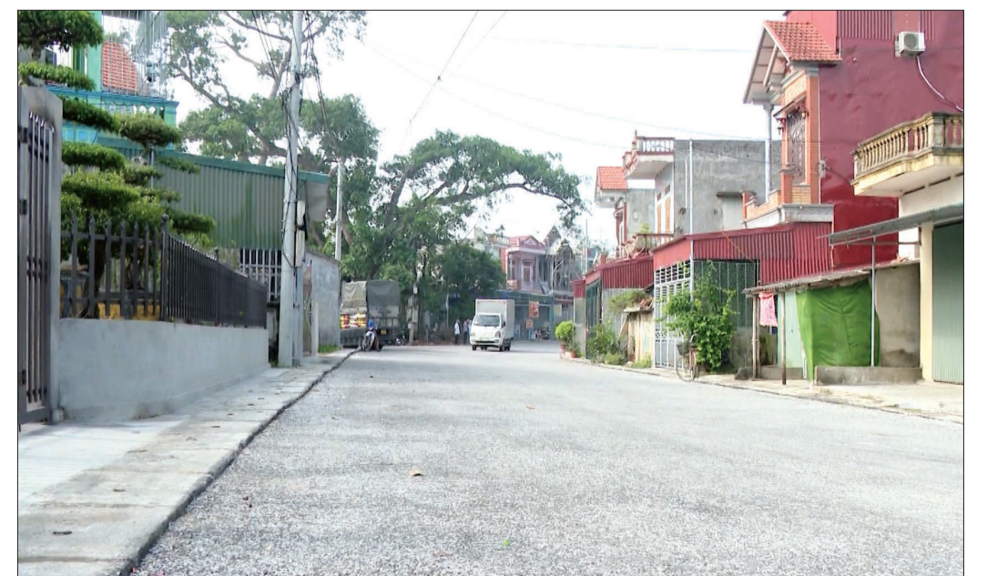
Tuyến đường tỉnh ĐT.452 đoạn qua xã Quỳnh Ngọc hoàn thành sẽ thúc đẩy kinh tế địa phương phát triển.
